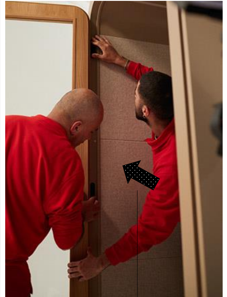
Sound Absorption (Blazer Fabric + 9mm PET) Insonorization (Tissu Blazer + 9mm PET) Absorción del Sonido (Tapizado Blazer + 9mm Panel PET) Absorção do Som (Tecidos Blazer + Painéis PET 9mm)
